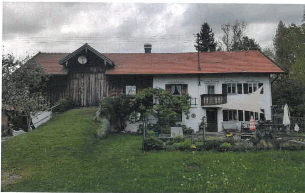
Abb. 2 bestehendes Hauptgebäude mit Tennenauffahrt
